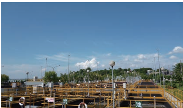
污水處理設施
